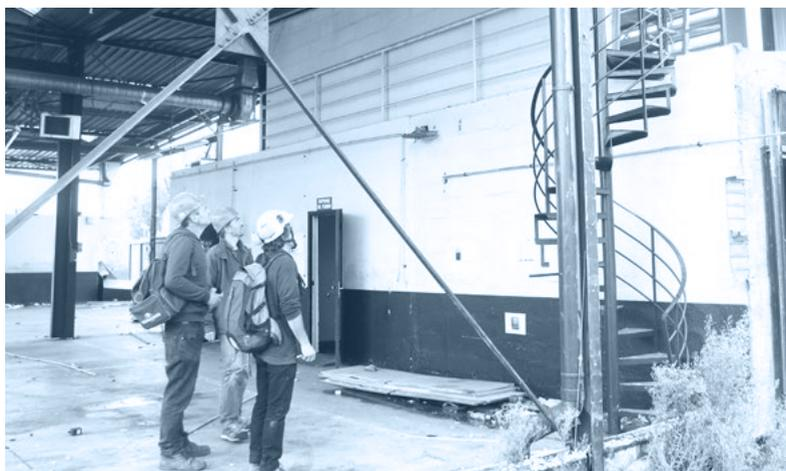
*Vérification de l'escalier bélicoïdal après Inventaire Ressources en vue de dépose par démolisseur*
